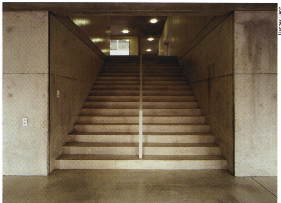
07 - ESCALERAS DE ACCESO A SEGUNDO PISO
